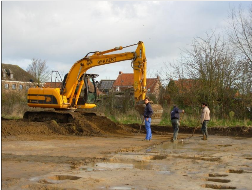
Woensdag 07/12/'11, 11u05: Openleggen uitbreiding terrein
